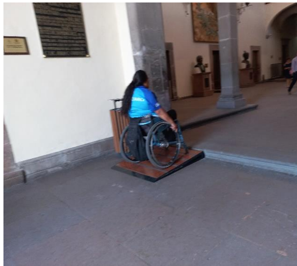
Figura 29. Escalón interior de la Casa de la Corregidora. Fuente: Propia.
